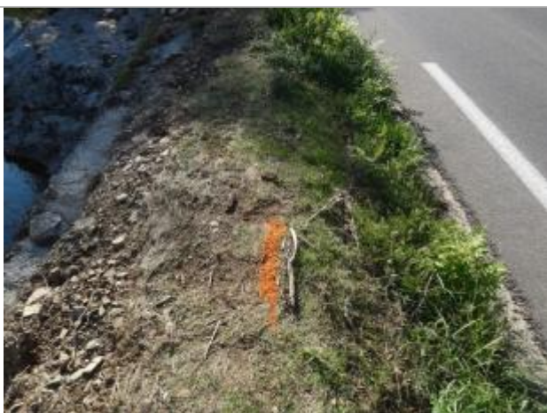
Vue du repère, photo OTEIS
