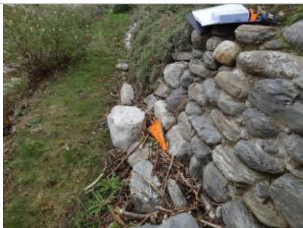
Vue du repère, photo OTEIS
