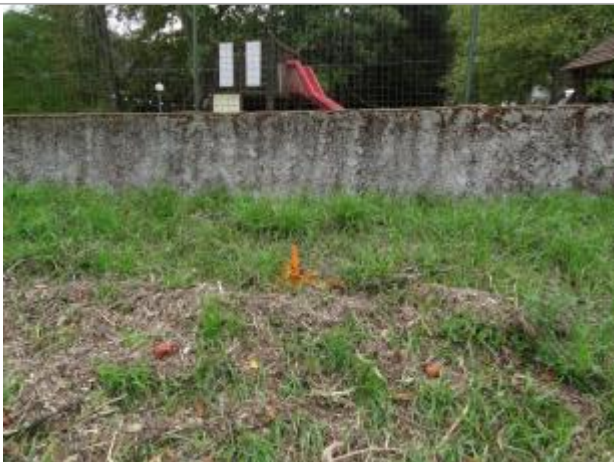
Vue du repère, photo OTEIS
