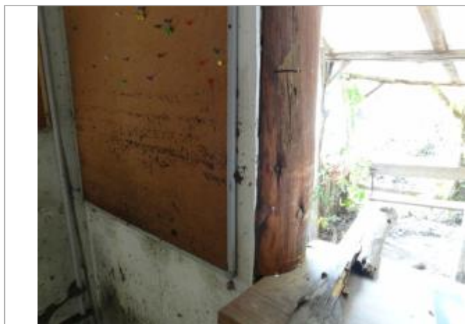
Vue du repère, photo OTEIS
