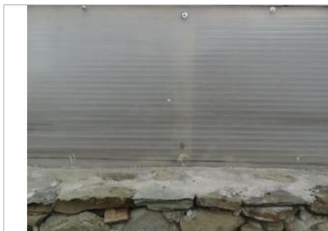
Vue du repère, photo OTEIS
