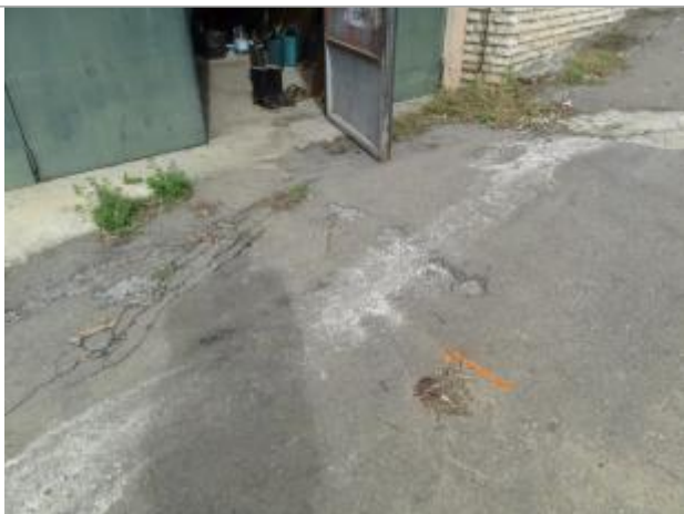
Vue du repère, photo OTEIS
