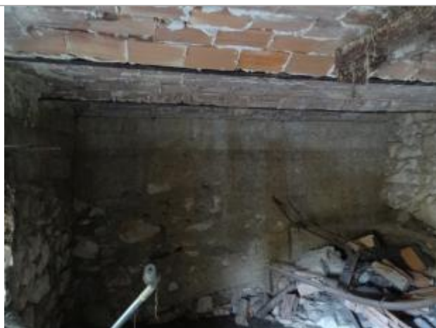
Vue du repère, photo OTEIS
