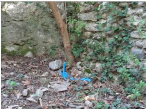
Vue du repère, photo OTEIS
