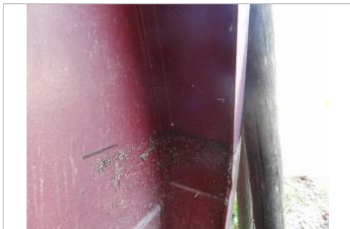
Vue du repère, photo OTEIS
