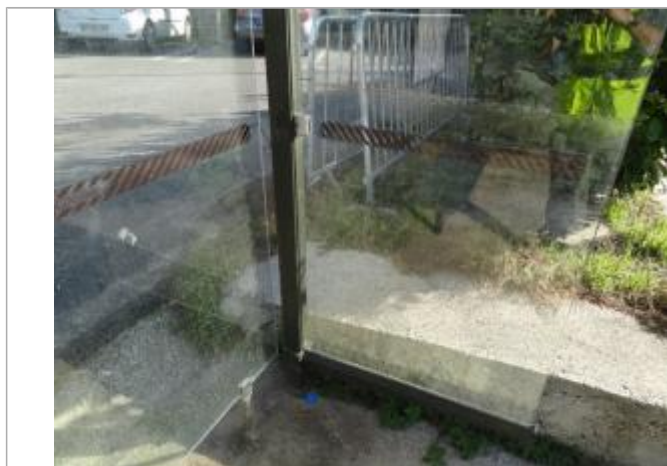
Vue du repère, photo OTEIS
