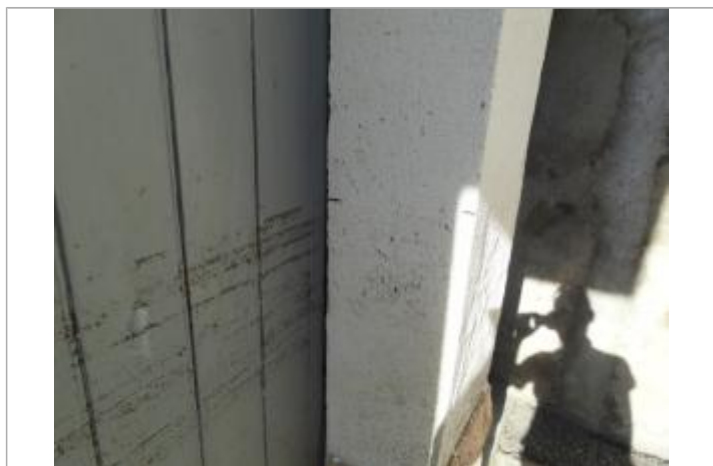
Vue du repère, photo OTEIS
