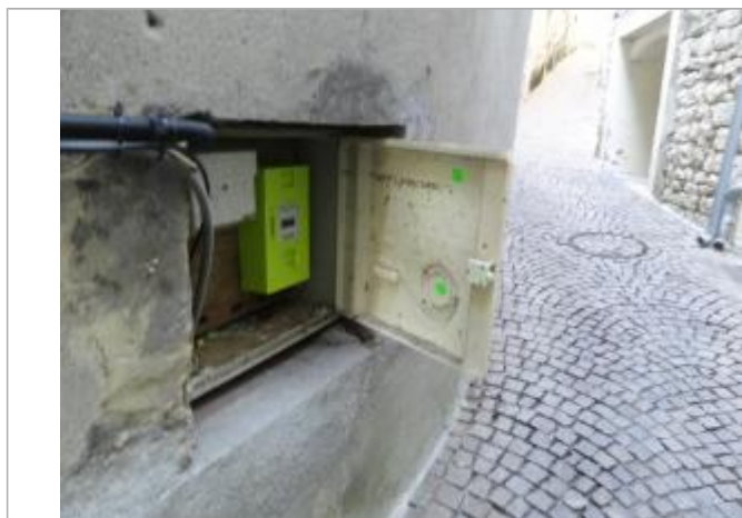
Vue du repère, photo OTEIS
