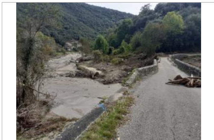
Vue du repère, photo OTEIS
