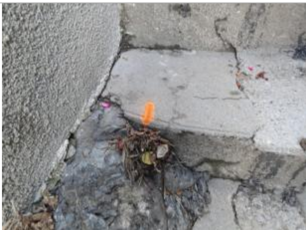
Vue du repère, photo OTEIS
