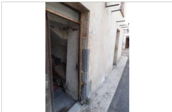
Vue du repère, photo OTEIS
