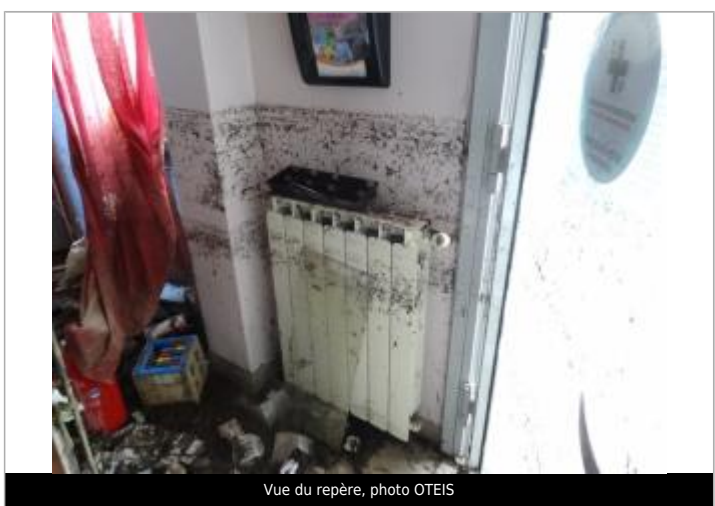
Vue du repère, photo OTEIS
