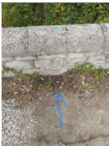
Vue du repère, photo OTEIS
