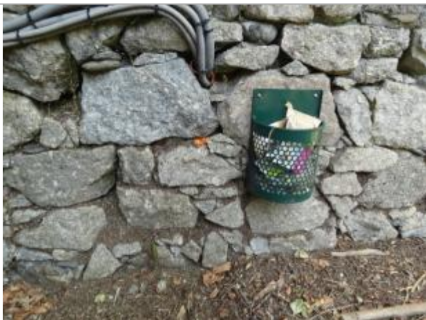
Vue du repère, photo OTEIS
