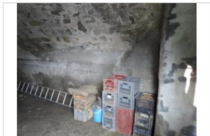
Vue du repère, photo OTEIS
