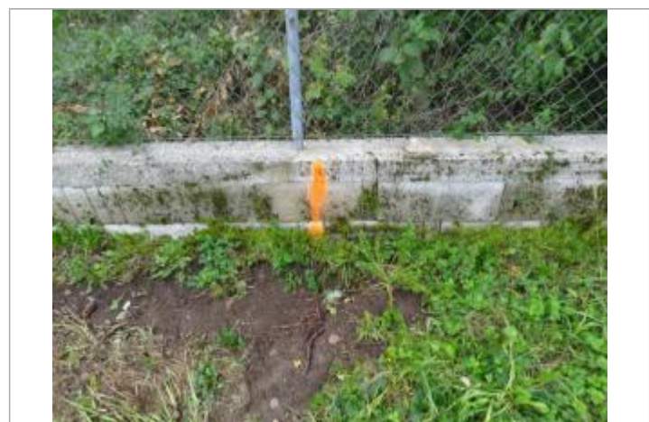
Vue du repère, photo OTEIS
