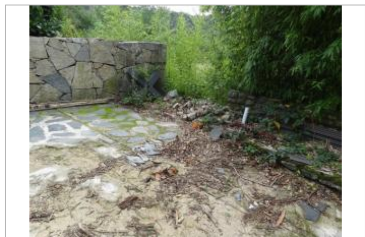
Vue du repère, photo OTEIS
