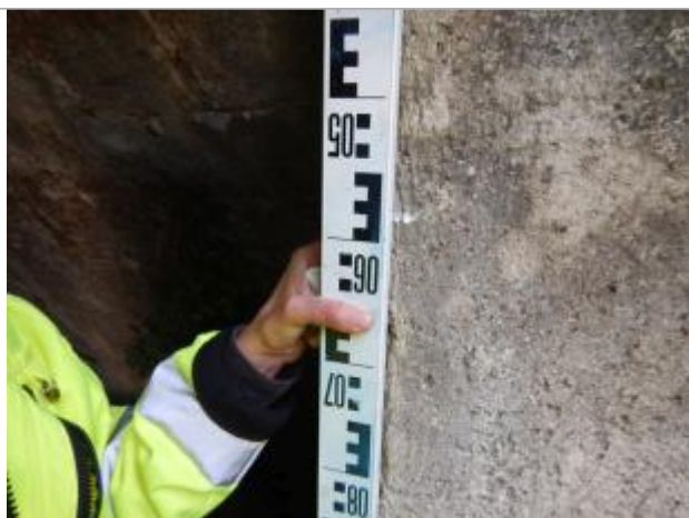
Vue du repère, photo OTEIS
