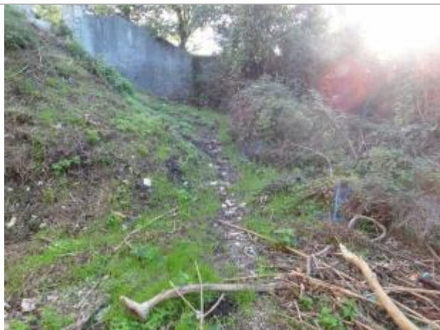
Vue du repère, photo OTEIS
