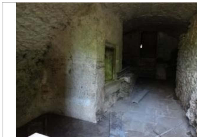
Vue du repère, photo OTEIS
