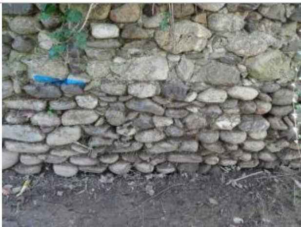
Vue du repère, photo OTEIS
