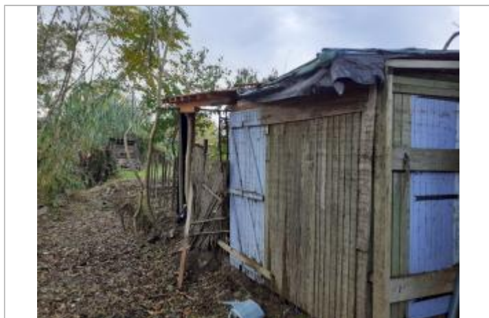
Vue du repère, photo OTEIS
