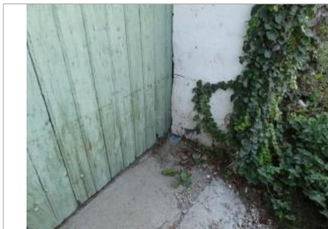
Vue du repère, photo OTEIS
