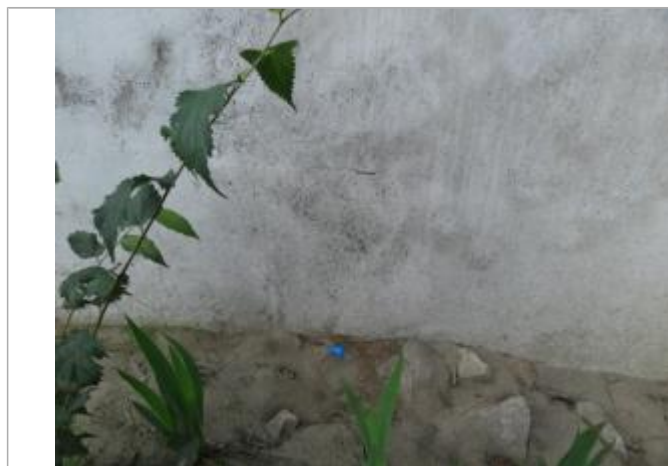
Vue du repère, photo OTEIS
