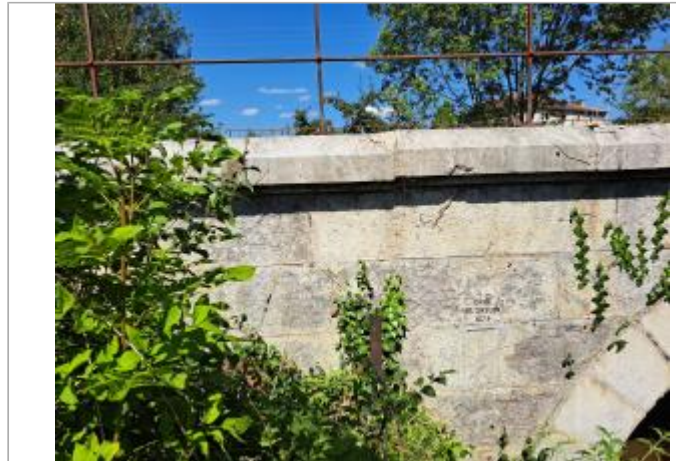
Ponceau de passage de la voie verte sur le ruisseau du Niart
