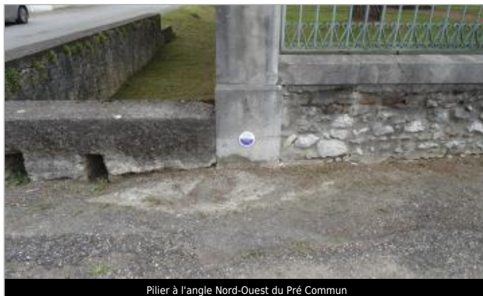
Pilier à l'angle Nord-Ouest du Pré Commun
