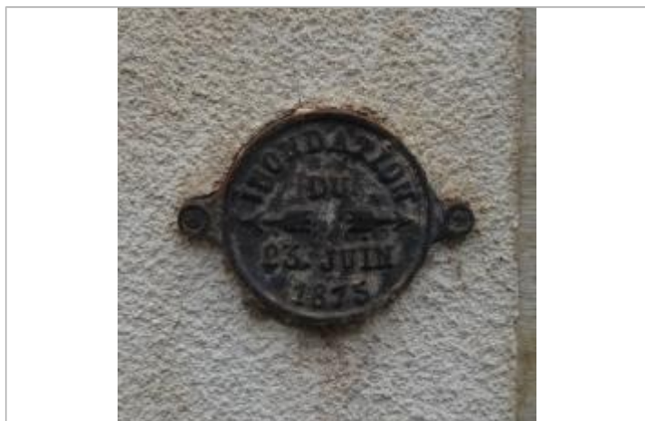
Plaque en fonte marquant le niveau d'eau atteint par la crue du 23 juin 1875 (PHEC)
