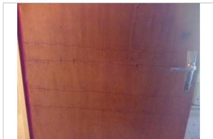
Trait au crayon marquant la PHE de la crue du 03/12/1995
