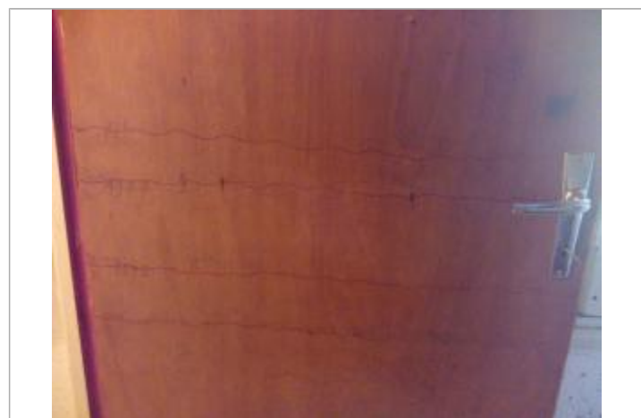
Trait au crayon marquant la PHE de la crue du 05/10/1992.
