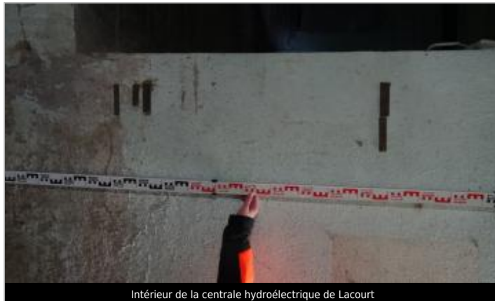
Intérieur de la centrale hydroélectrique de Lacourt
