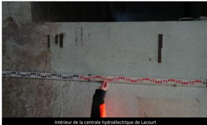
Intérieur de la centrale hydroélectrique de Lacourt
