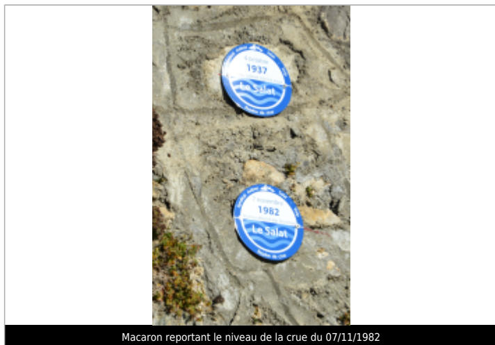
Macaron reportant le niveau de la crue du 07/11/1982
