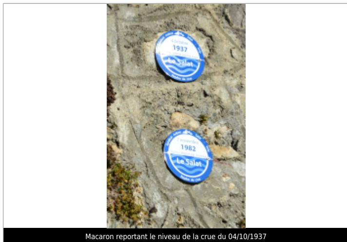
Macaron reportant le niveau de la crue du 04/10/1937
