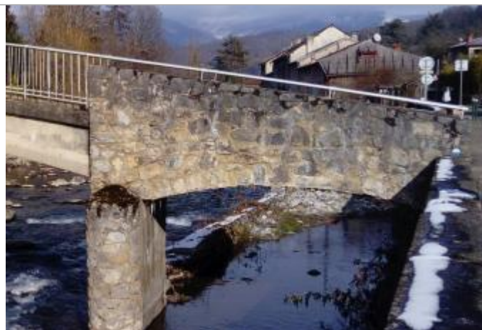
Vue amont de la passerelle sur le Salat
