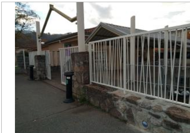
Muret de l'enceinte de l'établissement scolaire à côté de l'entrée principale
