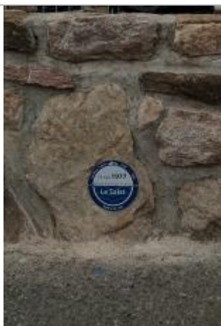
Macaron reportant le niveau de la crue du 19/05/1977
