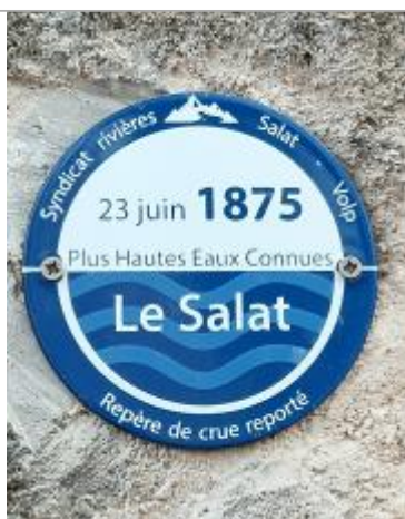
Macaron reportant le niveau de la crue du 23/06/1875 (PHEC)
