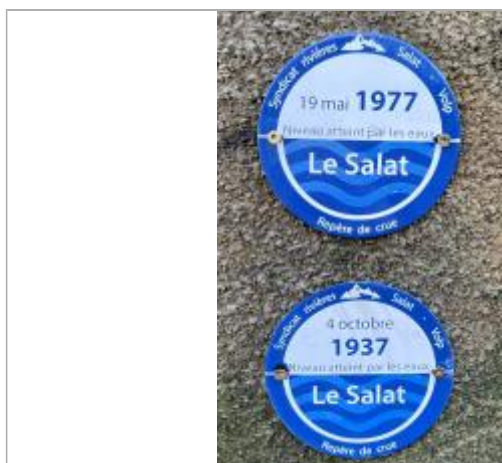
Macaron reportant le niveau de la crue du 04 octobre 1937
