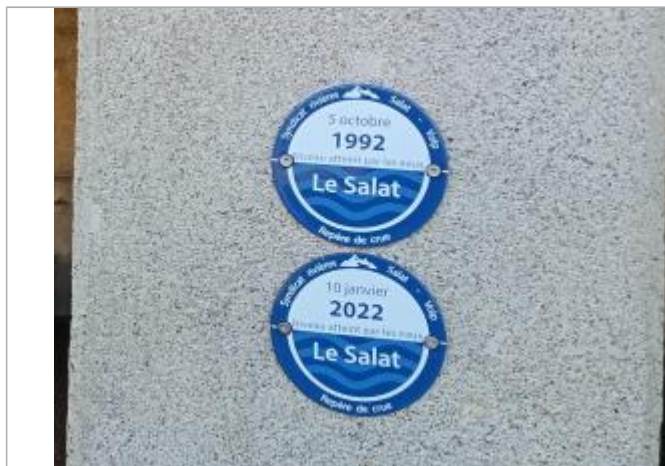
Macaron reportant la PHE de la crue du 10/01/2022
