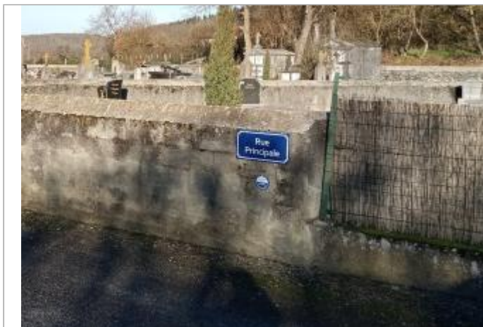
Mur d'enceinte du cimetière de Lacave
