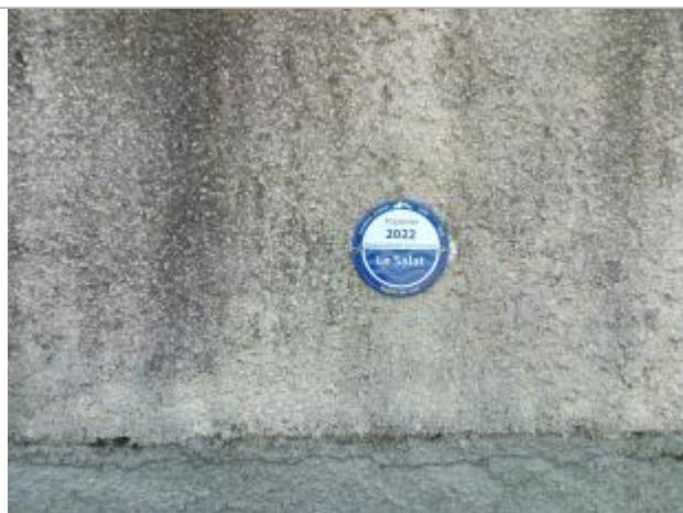
Macaron PHE reportée de la crue du 10 janvier 2022
