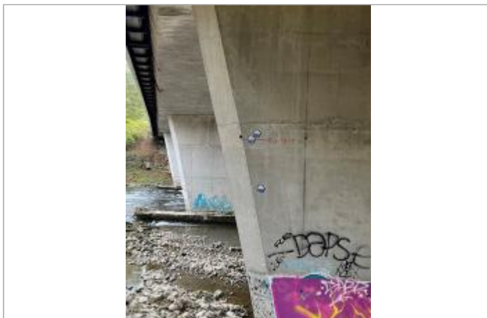
Pile du pont autoroutier de l'A64 sur le Salat
