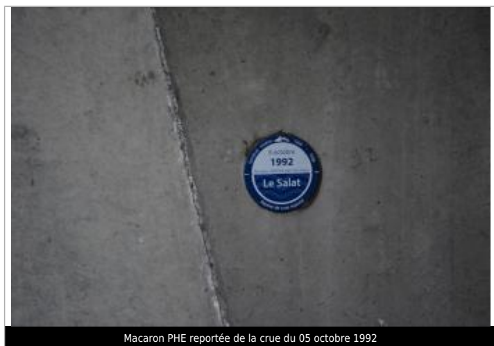
Macaron PHE reportée de la crue du 05 octobre 1992
