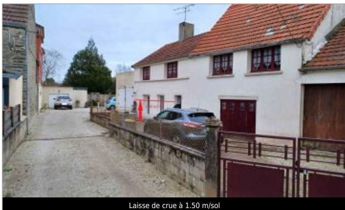
Laisse de crue à 1.50 m/sol
