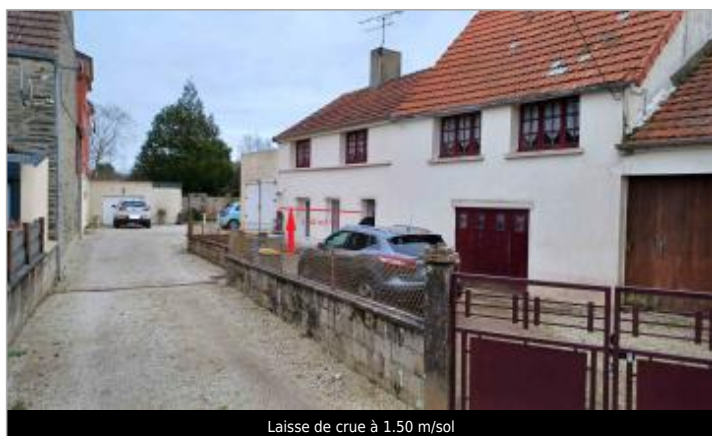
Laisse de crue à 1.50 m/sol
