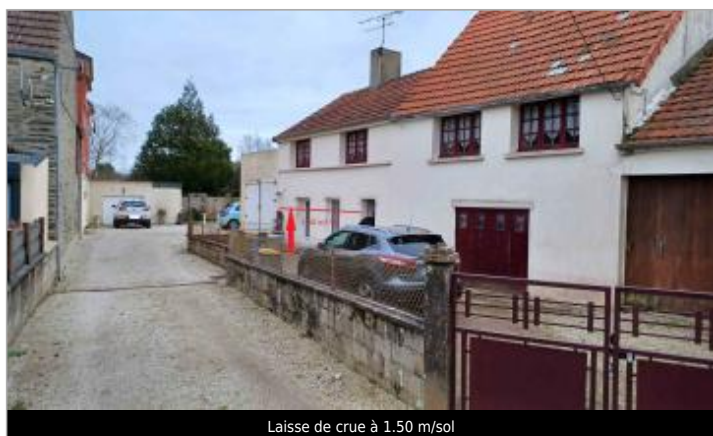
Laisse de crue à 1.50 m/sol
