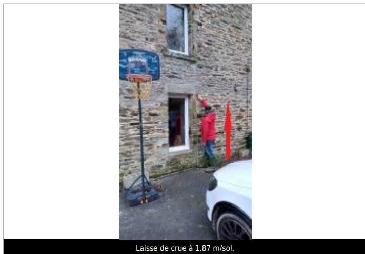
Laisse de crue à 1.87 m/sol.
