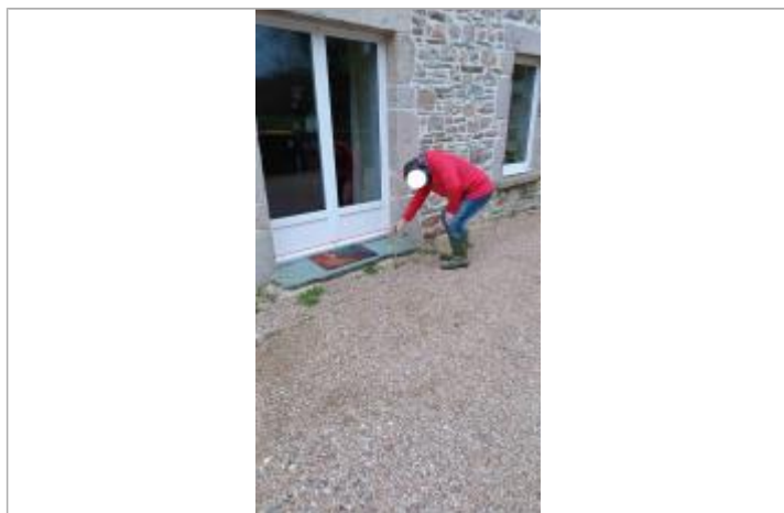
Laisse de crue à 15 cm/sol
